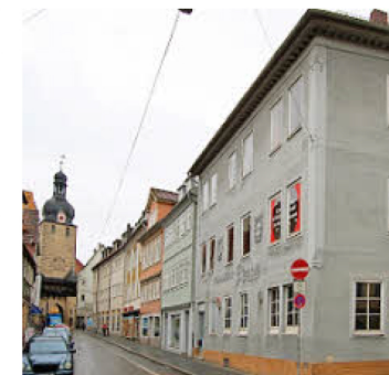
„Noch vor zwei Jahren wirkte das Gebäude heruntergekommen und schäbig.“
