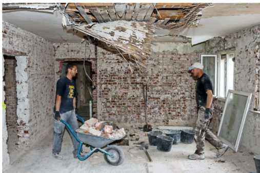
Draußen und drinnen wird bis auf die Grundmauern entkernt.
